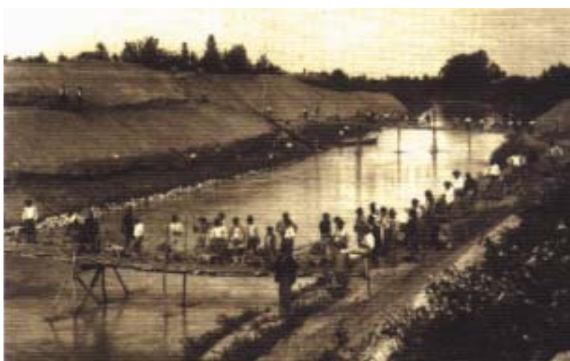
Scariolanti addetti alla costruzione del nuovo Cavo condotto del Panaro presso Finale Emilia, 1885 circa. (Foto Magni, archivio Carc, Finale Emilia).
